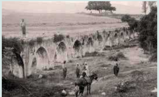
Aqueducs de Ras El Aïn – au sud de la ville de Tyr
