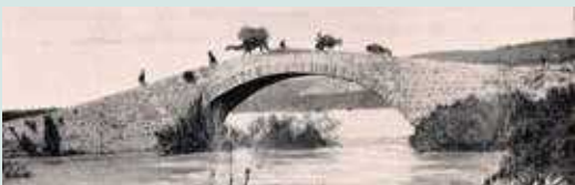
Pont de Qasmiyeh – au nord de la ville de Tyr
