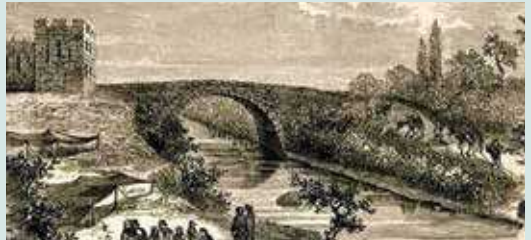
Pont de l'Awali – au nord de la ville de Saïda
